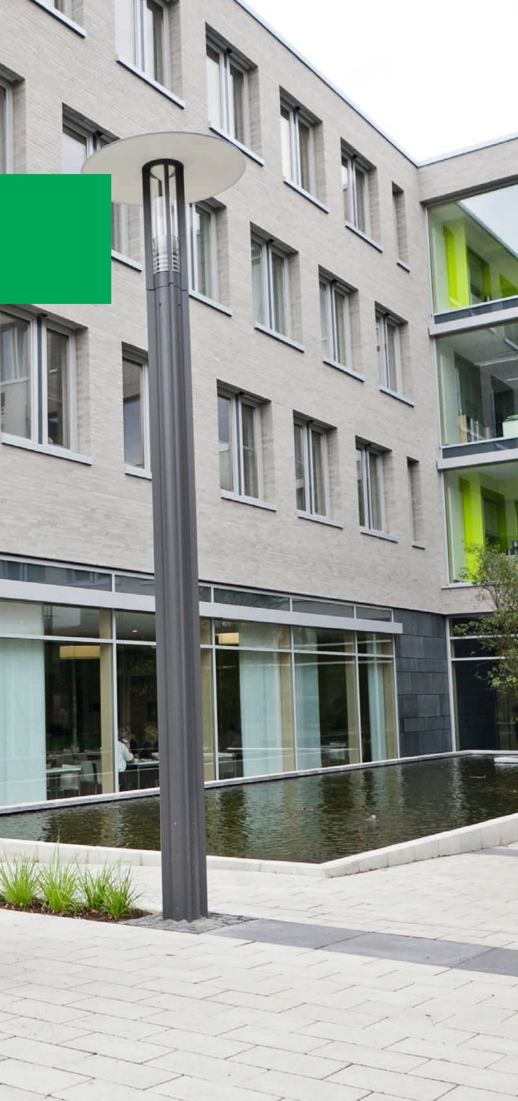
Nachhaltig in Richtung Zukunft – das neue Direktionsgebäude.
