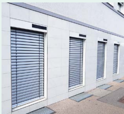
Solarbetriebene Jalousien im AOK-RückenStudio Waiblingen.
