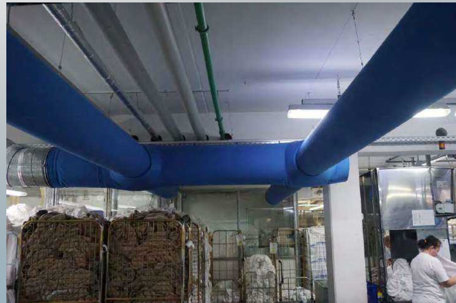
Heute – automatische Lüftungsanlage
